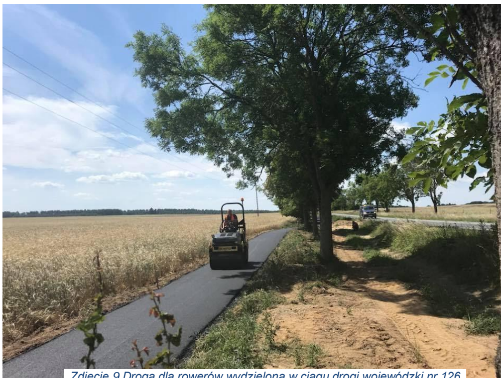
Zdjęcie 9 Droga dla rowerów wydzielona w ciągu drogi wojewódzkiej nr 126
