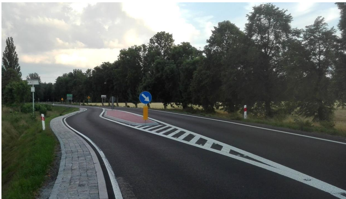
Zdjęcie 7 Esowanie toru jazdy na wjeździe w teren zabudowany wsi Stupulów
