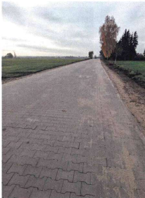
Fot. Droga gminna w m. Głuchowo.
