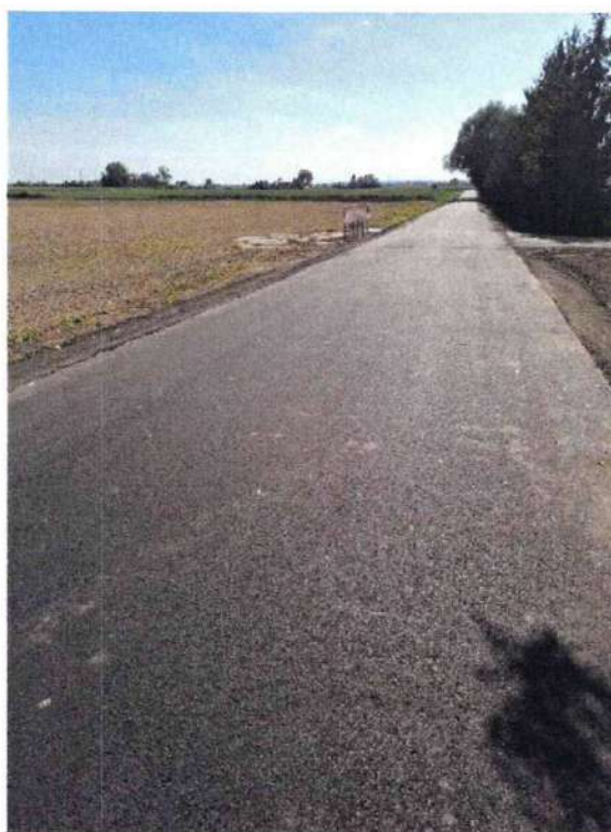
Fot. Droga gminna w m. Stare Miasto-Marianowo.
